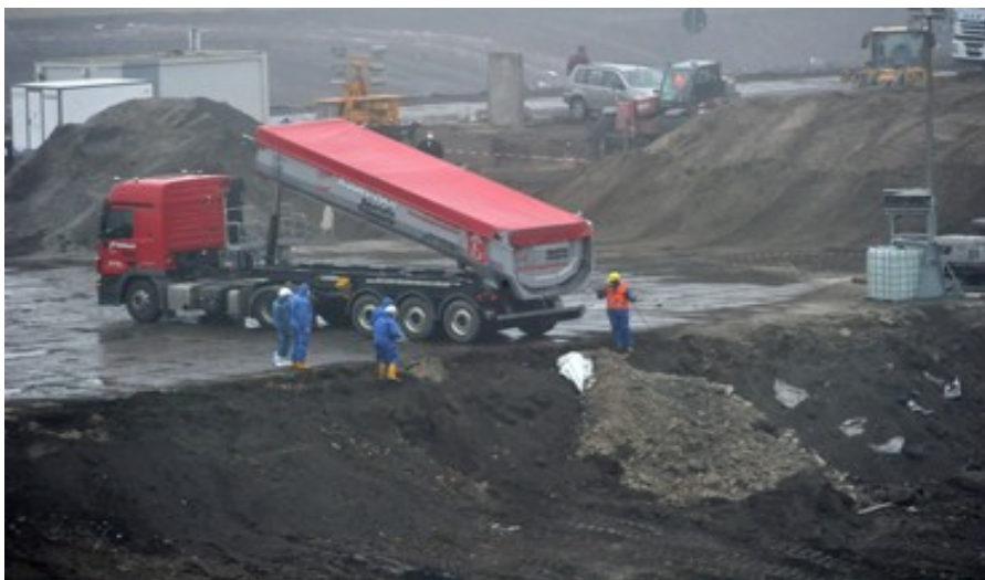
Foto des Abkippvorgangs einer „Testfahrt“ auf die Deponie Ihlenberg, Kipphöhe ca. 4 Meter.
