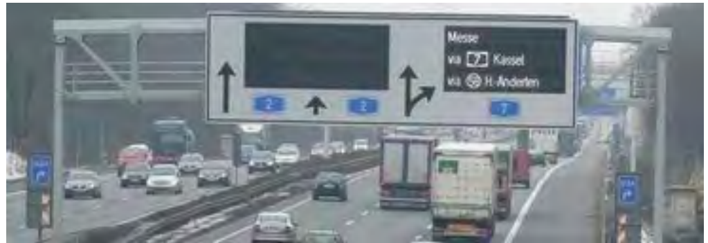
Abb. 5 Beispiel für einen dynamischen Wegweiser mit integrierter Stauinformation (dWiSta)
